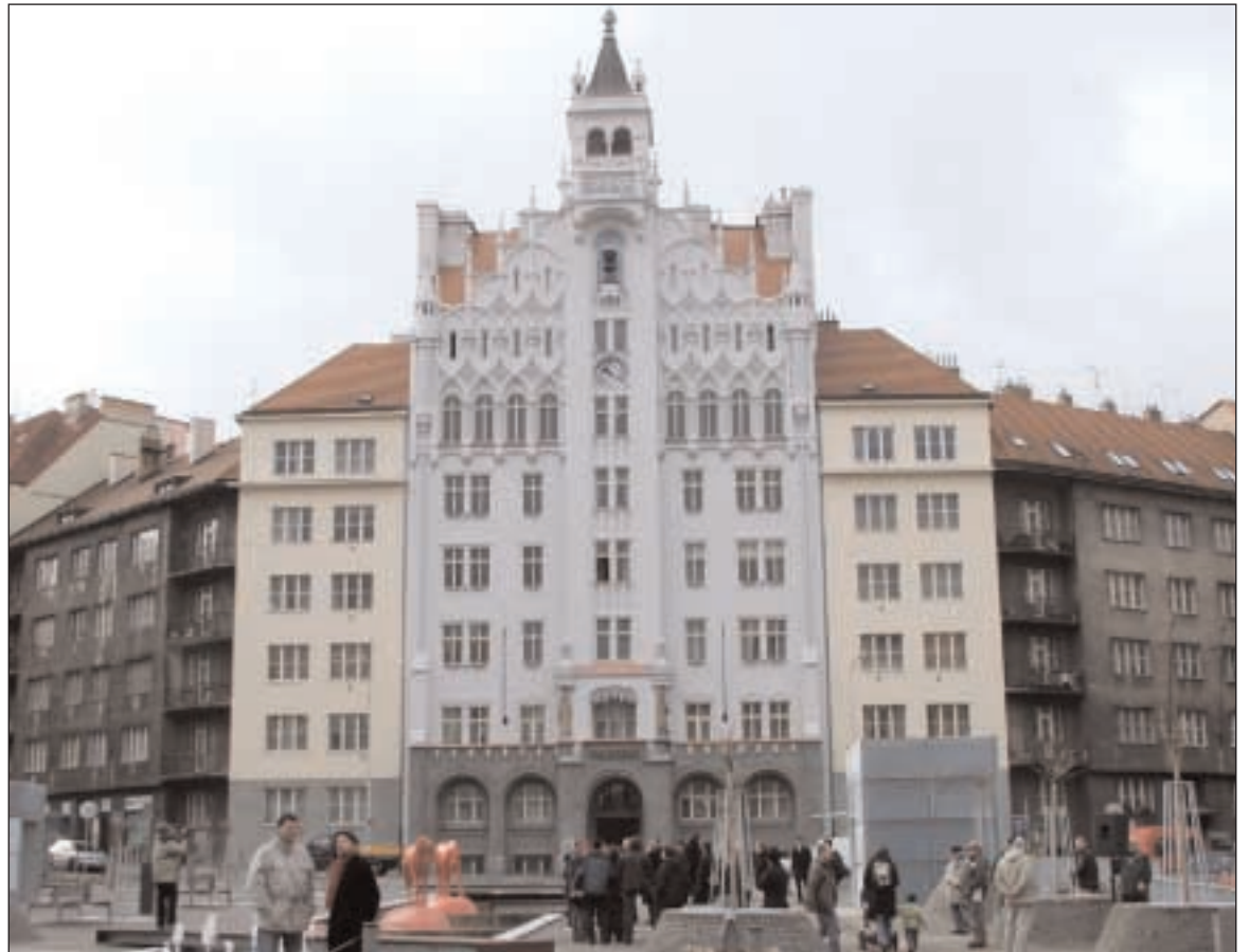
S dokončením rekonstrukce náměstíčka vyniká opravená fasáda budovy ústředí naší církve
