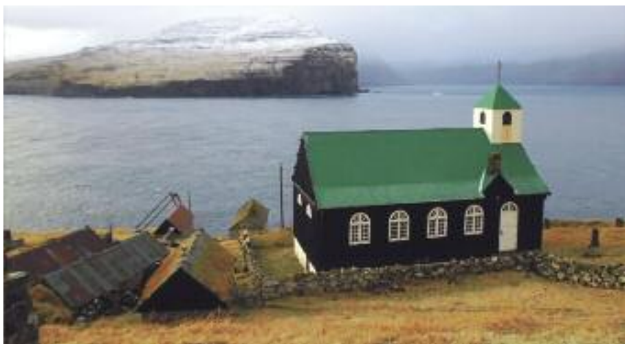
Kostel v obci Kirkja na ostrově Fugloy
